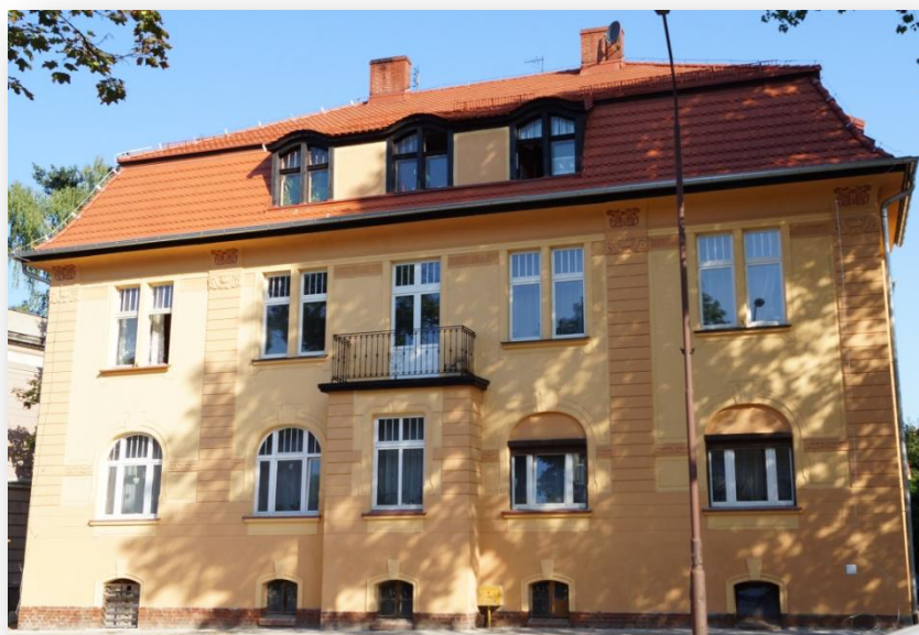
Rewitalizacja wielorodzinnych budynków mieszkalnych położonych przy ul. Wojska Polskiego nr 44, ul. Wojska Polskiego nr 46 oraz ul. Wojska Polskiego nr 60 w Jeleniej Górze – al. Wojska Polskiego 60
