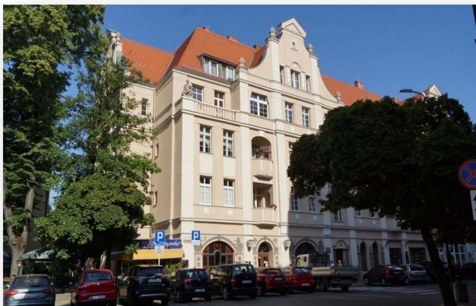
Rewitalizacja budynku przy ul. Pocztowej 6 w Jeleniej Górze
