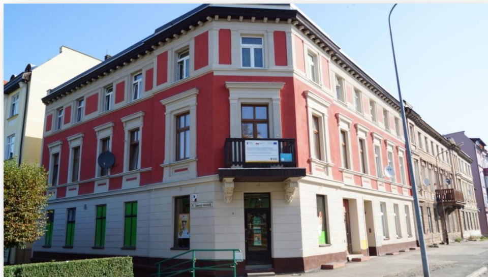
Rewitalizacja wielorodzinnych budynków mieszkalnych położonych przy ul. Wojska Polskiego nr 7, ul. Wojska Polskiego nr 10 oraz ul. Wojska Polskiego nr 11 w Jeleniej Górze - al. Wojska Polskiego 10
